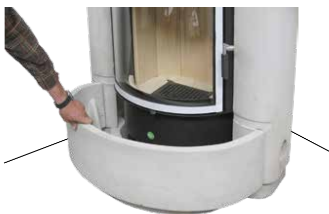
7. Sockeloberteil ohne zu Verkleben auf das Sockelunterteil setzen und mit Wasserwaage den richtigen Sitz kontrollieren.
