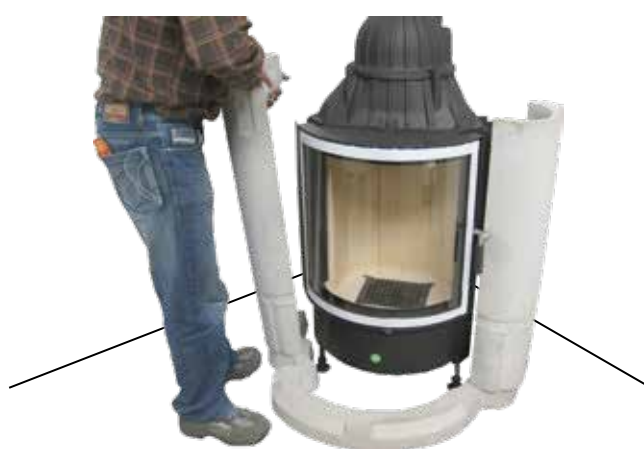
6. Säulen rechts und links ohne zu Verkleben auf die vorgegebene Kontur am Sockelunterteil setzen
