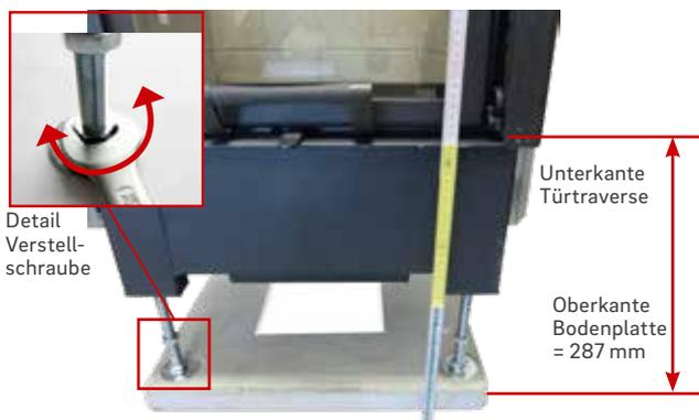
7. Kamineinsatz positionieren und mit Hilfe der Verstell-schrauben (SW 24) von Oberkante Bodenplatte aus auf eine Höhe von 287 mm einstellen...
