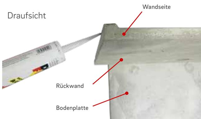
12. Anlage zurückbauen und alle Teile mit Acrylkleber neu setzen. Die Rückwände wie abgebildet mit der Zimmerwand verkleben.
