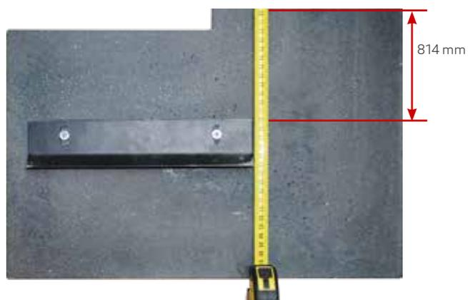
18. Unteren Haltewinkel von **Oberkante Frontplatte** im Abstand von 810 mm mit Senkkopfschraube M 6x 12 mm rückseitig montieren.
