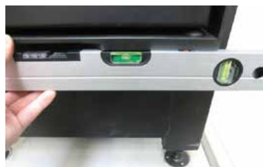
8. ...und mit Wasserwaage ausrichten.
