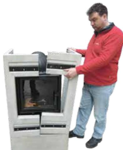
10. Seitenteile rechts und links **ohne zu Verkleben** auf die Bodenplatte oder das Podest setzen (Kamineinsatz evtl. nachjustieren).
