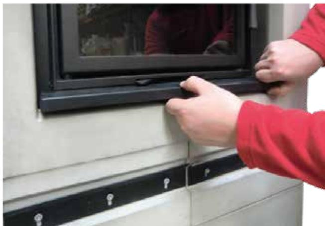
14. Die untere Innenblende (B 95 mm) wird mit Acrylkleber im Abstand von 2 – 3 mm zum Zargenrahmen und bündig zur vorderen Anlagenfläche gesetzt.
