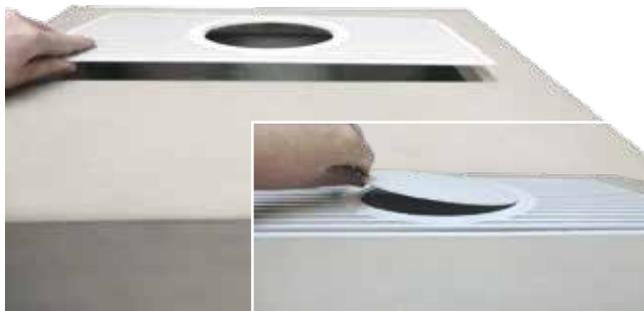
13. Deckengitter und Einlegedeckel in die vorgesehene Öffnung einsetzen.
