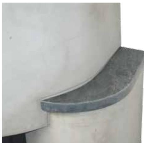
19. Naturstein-Ablageplatten rechts und links auf die Säulen legen und punktuell verkleben. Die Anschlussfugen spritzen Sie bitte mit Acrylkleber ab.
