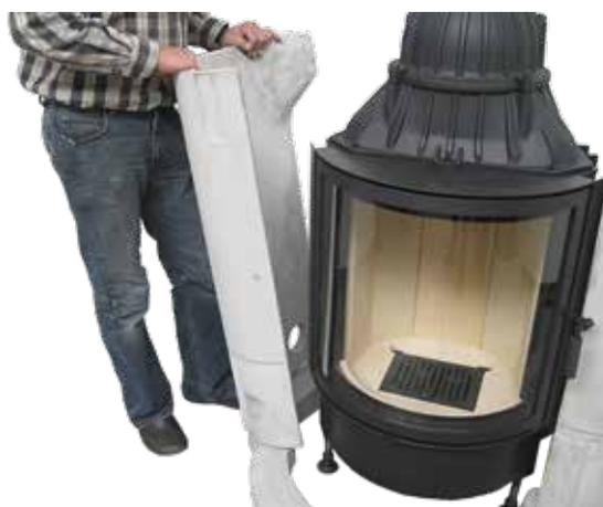
6. Säulen rechts und links **ohne zu Verkleben** auf die vorgegebene Kontur am Sockelunterteil setzen
