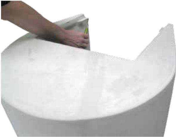
15. Anlage jetzt zurückbauen und für die rückseitige Dämmung (8 cm) die Innenkonturen an die Wand markieren.
