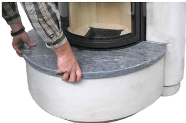
18. Naturstein-Sockelplatte auf Sockelunterteil setzen und punktuell verkleben. Kleber auf Natursteinplatten entfernen Sie am besten mit einem feuchten Tuch.
