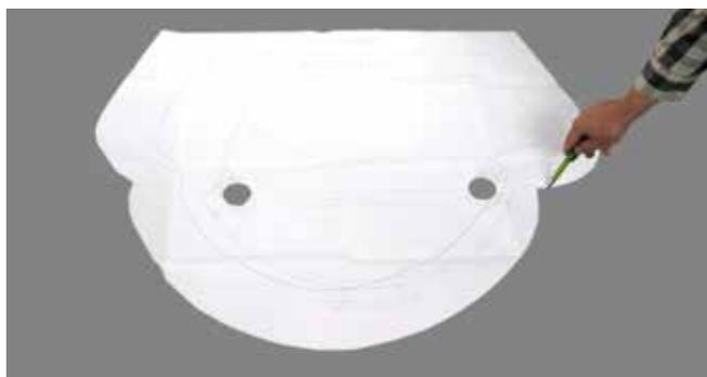
1. Schablone positionieren, Stellfüße vom Kamineinsatz sowie die Sockelkonturen und die Dämmung (zur Wand) markieren.
