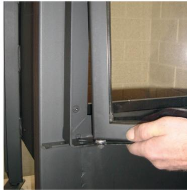
4. Den Türflügel schräg zum eigenen Körper hin und gleichzeitig nach unten ziehen, bis sich der obere Bolzen aus dem Zargenrahmen löst.
