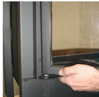
3. Den Türflügel zusammen mit dem Spannschlüssel nach oben drücken, bis der Bolzen aus der unteren Öffnung im Zargenrahmen heraustritt.
