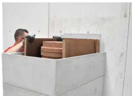
6. Schamotteplatten Höhe 750 mm von oben (auf beiden Seiten) auf die Zarge vom Kamineinsatz setzen und an den Schamotteringen anlehnen.
