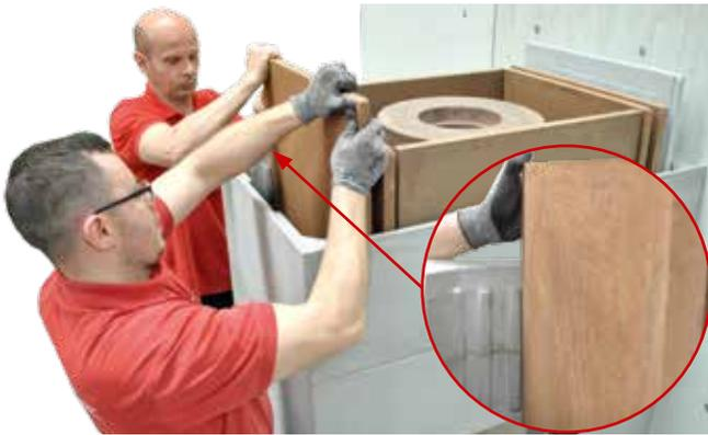
7. Obere Schamottegussplatten 2x Höhe 510mm gleichmäßig von oben in die vorgesehenen Führungsrippen der Anlage setzen (Falzseite zeigt zur Wand).
