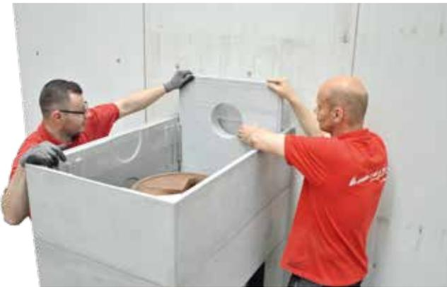
1. Obere Dämmplatte (mit der angeschrägten Seite zur Wand) gleichmäßig von oben in die vorgesehenen Führungsrippen der Anlage, auf die untere Dämmplatte setzen.
