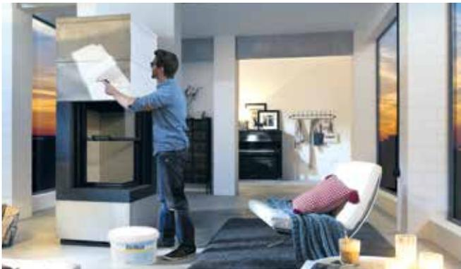
**⚠ HINWEIS:** Um die **Materialspannungen abzubauen, ist die Kaminanlage vor der Oberflächengestaltung einmal aufzuheizen! Max. Holzauflagemenge siehe „5.1 Funktionsprinzip und wichtige Daten“ auf Seite 8. Risse in der Oberfläche werden hierdurch reduziert bzw. verhindert.**
