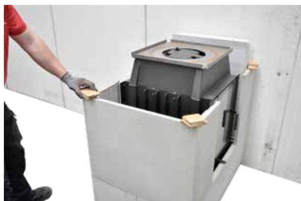
13. Zur Montageerleichterung bitte aus den Verpackungsstreifen der Anlage, die Faserplatten auf allen vier Ecken doppelt auflegen.
