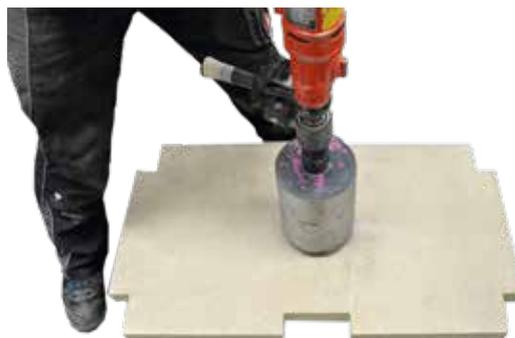
13.... und der Innen-Deckenplatte (5cm Vermiculite) anzeichnen und beide Platte bohren.
