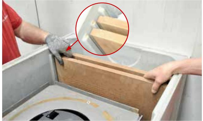
16. Die mittleren Schamottegussplatten mit der Höhe 800 mm gleichmäßig von oben in die vorgesehene Führungsrippen an der Wandseite der Anlage einsetzen (Falzseite der Platten zeigt zur Wand).
