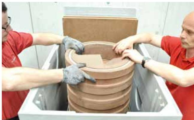
4. Vierten Schamottering mit Anschlussbohrung auflegen und Drehzugrichtung durch Verdrehen einstellen.
