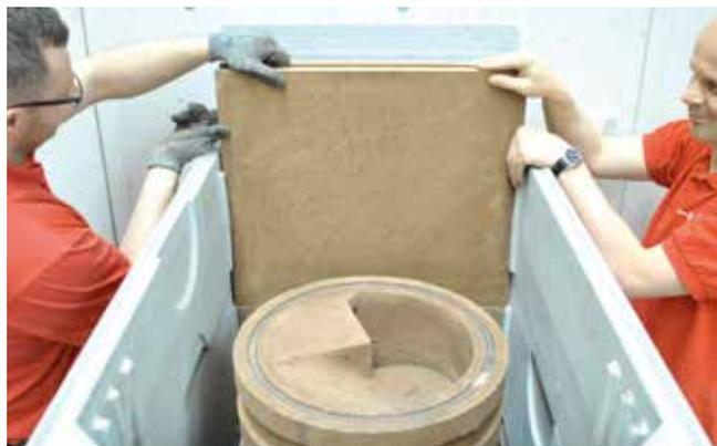
2. Obere Schamottegussplatten mit der Höhe 510 mm (zur Wandseite) gleichmäßig von oben in die vorgesehenen Führungsrippen der Anlage setzen (Falzseite zeigt zur Wand).
