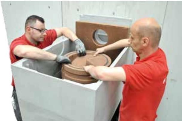
3. Dritten Schamottering auflegen und Drehzugrichtung durch Verdrehen einstellen. Die Kantenlinien der Übergänge müssen übereinanderliegen.
