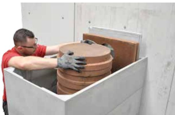
5. Abschluss-Schamottering mit Anschlussbohrung auflegen und Drehzugrichtung durch Verdrehen einstellen.
