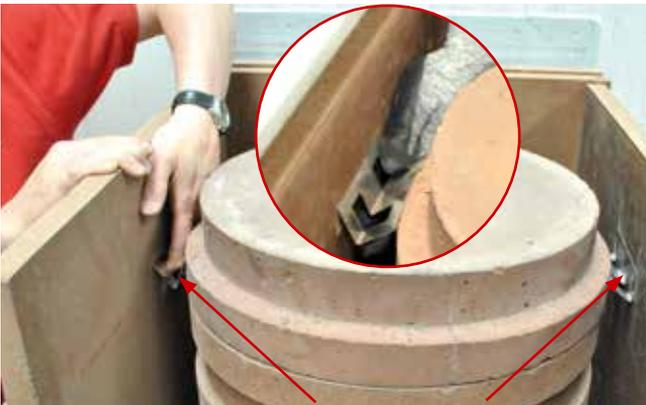
9. Zur Fixierung der beiden Schamotteplatten werden auf beiden Seiten zwischen Schamottering und Schamotteplatte von oben jeweils zwei Edelstahlhaltefedern (oben und unten) eingedrückt..
