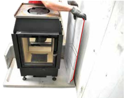
6. Untere Dämmplatte (mit der geschrägten Seite zur Wand) auf die Bodenplatte und vor das Unterbauteil setzen.
