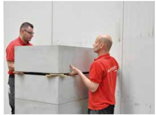
8. Zur Montageerleichterung bitte die Faserplatten wieder auf allen vier Ecken positionieren und das Haubenteil ohne zu verkleben setzen (Faserplatten wieder entfernen). Dabei ist zu Beachten, dass die Schamottegussplatten in den Führungsrippen positioniert werden.
