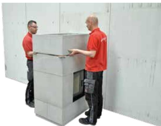
23. Zur Montageerleichterung bitte die Faserplatten erneut auf allen vier Ecken auflegen und das Mittelteil **ohne zu verkleben** setzen (dann die Faserplatten wieder entfernen).
