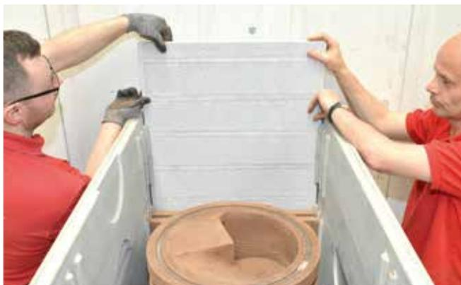
1. Obere Dämmplatte (mit der angeschrägten Seite zur Wand) gleichmäßig von oben in die vorgesehenen Führungsrippen der Anlage, auf die untere Dämmplatte setzen.
