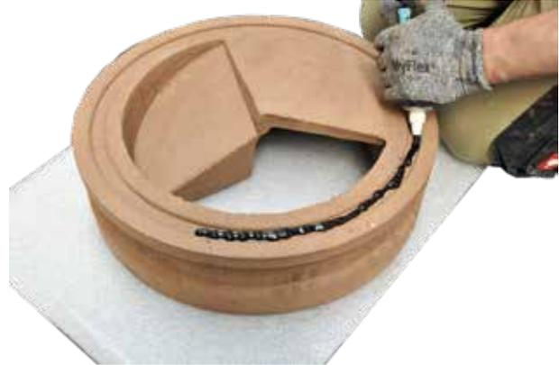
18. Der erste Schamottering hat auf der Unterseite eine Nut für die Dichtschnur. Bitte den beiliegenden Kleber in die Nut auftragen...
