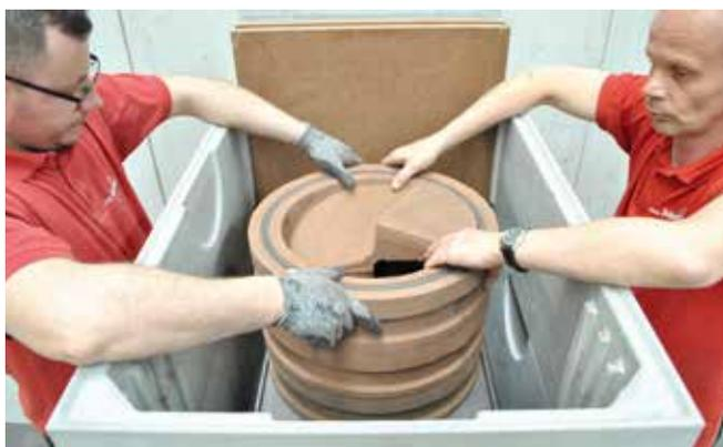
3. Dritten Schamottering auflegen und Drehzugrichtung durch Verdrehen einstellen. Die Kantenlinien der Übergänge müssen übereinanderliegen.
