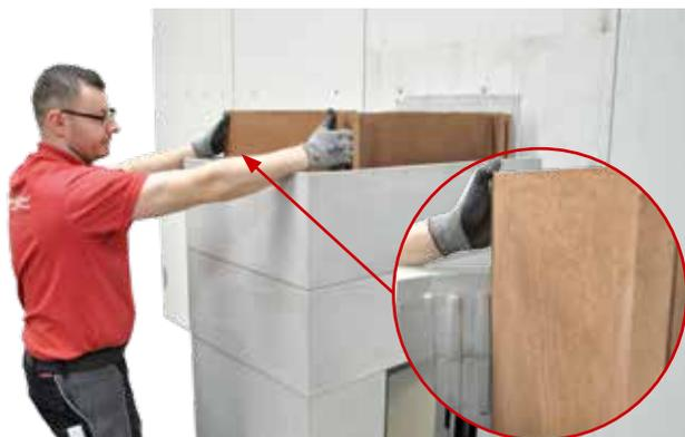
7. Obere Schamottegussplatten 2x Höhe 510 mm gleichmäßig von oben in die vorgesehenen Führungsrippen der Anlage setzen (Falzseite zeigt zur Wand).
