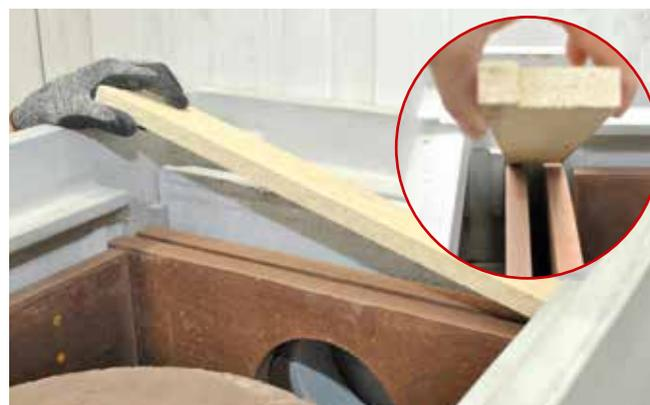
10. Abdeckleisten (aus Vermiculite) bitte auf beiden Schamotteguss-Innenwänden Wandseite und vorne auflegen.
