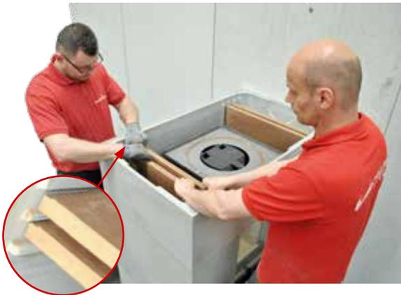
17. Auf der gegenüberliegenden Seite jetzt die Schamotteplatten Höhe 1000mm gleichmäßig von oben in die vorgesehene Führungsrippen der Anlage setzen (Falzseite der Platten zeigt zur Wand).
