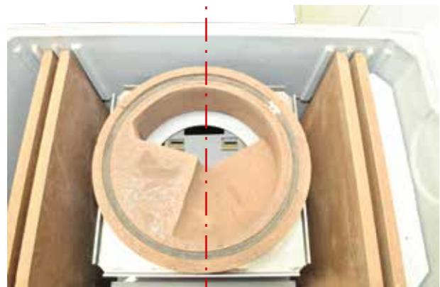
20. Den ersten Schamottering jetzt mit der eingeklebten Dichtschnur nach unten auf die Adapterplatte vom Kamineinsatz legen. **Die sichtbare Öffnung mittig zur Anlage ausrichten!**
