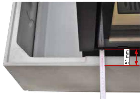
8. Kamineinsatz ausrichten: Abstand von Vorderkante der Zarge bis Außenfläche der Verkleidung (vorne) = 51 mm.
