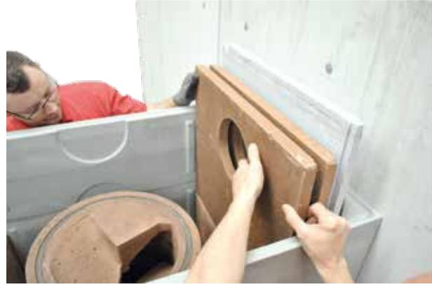
2. Obere Schamottegussplatten mit der Höhe 510 mm (zur Wandseite) gleichmäßig von oben in die vorgesehenen Führungsrippen der Anlage setzen (Falzseite zeigt zur Wand).
