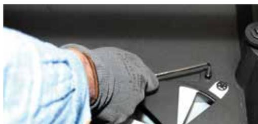
21. Schrauben Sie den Verbrennungsluftstutzen und den Drehschieber mit den vier Schrauben am Boden wieder fest. Ziehen Sie alle vier Schrauben mit dem Innensechskantschlüssel 5 mm gleichmäßig fest. Die Montage beim Verbrennungsluftstutzen  $\varnothing$  125 mm ist hier beendet.
