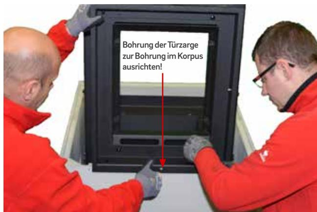
13. Türzarge und Fülltür über die Achse vor den Adapterrahmen drücken und mit vier Innensechskantschrauben befestigen.
