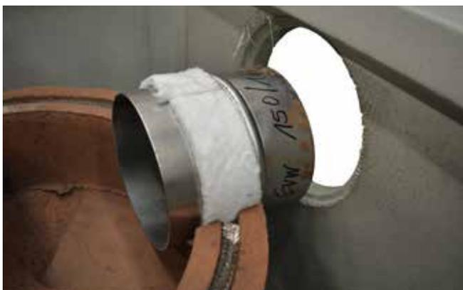
68. Rohrerweiterung  $\varnothing 150$  mm auf  $\varnothing 160$  mm jetzt mit den Dichtungsvlies in die Anschlussbohrung setzen.
