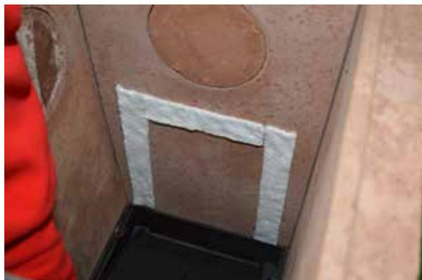
41. Dichtungsvlies für den Sekundärluftkanal ausschneiden und punktuell mit Kleber fixieren.
