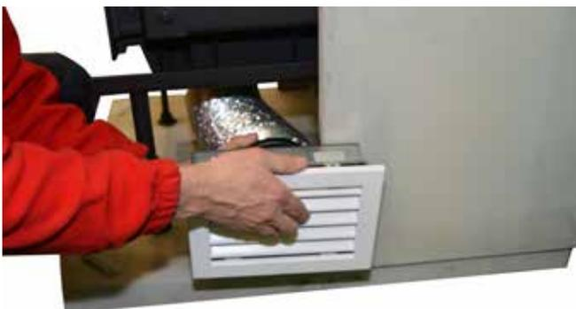
3. Lamellengitter in den Einbaurahmen drücken.
