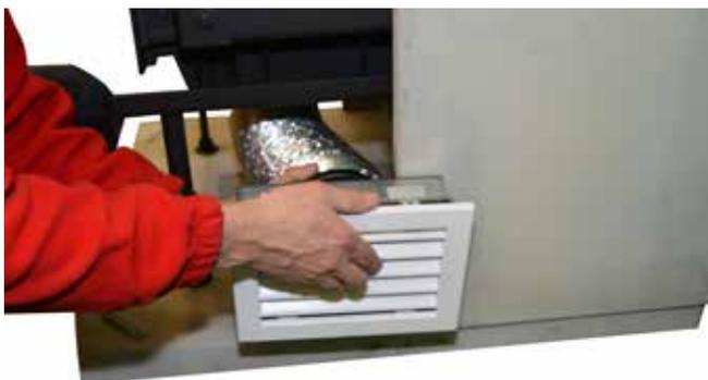
73. Lamellengitter in den Einbaurahmen drücken.
