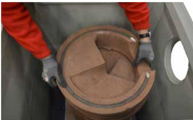
66. Fünften Schamottering mit Anschlussbohrung auflegen und Drehzugrichtung durch Verdrehen einstellen.
