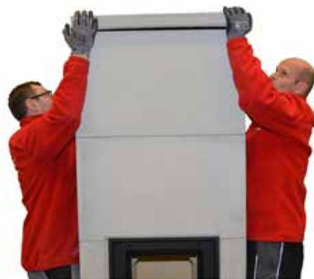
82. Deckenplatten vorsicht auflegen und ausrichten.
