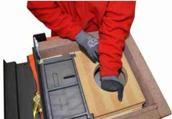
49. Guss-Abdeckplatte und den Schamotte-Abdeckstein auf die oberen Seitensteine einsetzen.
