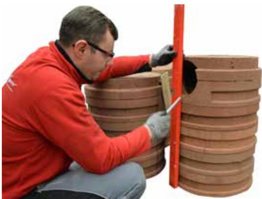
56. Mit der Wasserwaage Mittig am Anschluss eine senkrechte Montagehilfslinie zeichnen (**nur bei Wandanschluss**).
