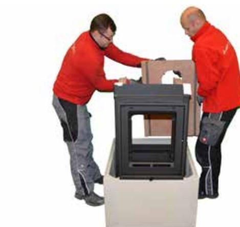
38. Setzen Sie die Rückwand vor die Seitenteile. Verkleben Sie die Fugen zu den Seitensteinen erst nach der Trockenmontage.
