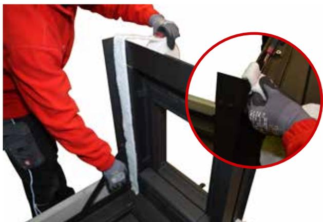
35. Dichtungsvlies rechts/links zuschneiden. Tipp: oben etwas länger lassen und über die Korpuswand hängen.
