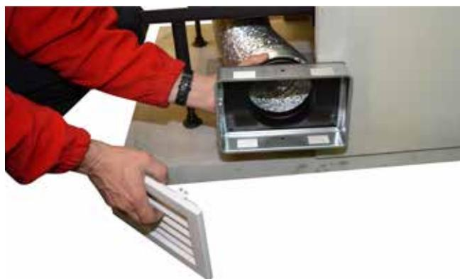
2. In den Unterbauteilen sind die Einbaupositionen rechts und links innen vorgeben. Bitte den Ausschnitt laut innenliegender Kontur genau für den Einbaurahmen ausschneiden. (Tipp: Stichsäge mit Diamantblatt verwenden und Schnittkanten aussen abkleben). Aluflexschlauch anschliessen und Einbaurahmen montieren.
