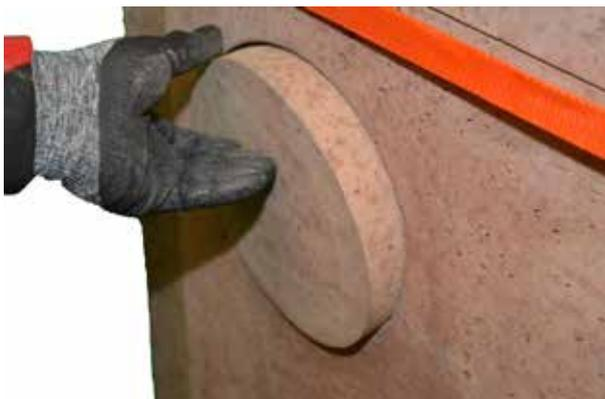
40. Verschlussdeckel in die Rauchgasöffnung der Seitenteile und Rückwand einkleben.
