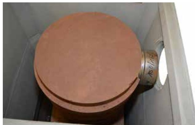
69. Abschluss Schamottering mit Anschlussbohrung auflegen.
