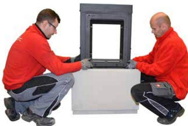
11. Grundkorpus auf dem Traglager etwas vorziehen (Vorderwand Grundkorpus mit der Abkantung am Traglager vorne bündig).
