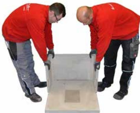
3. Hinteres Unterbauteil **ohne zu verkleben** auf die Bodenplatte setzen.
