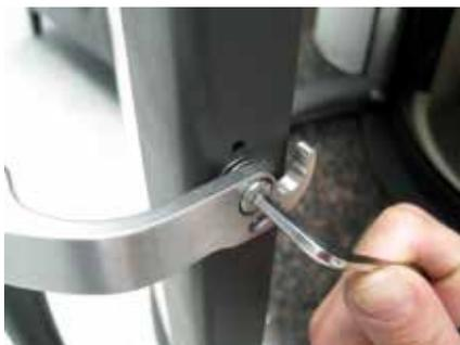
3. Inbusschraube M6 x 12 mm mit Sechskantschlüssel am Türrahmen fest anschrauben.
