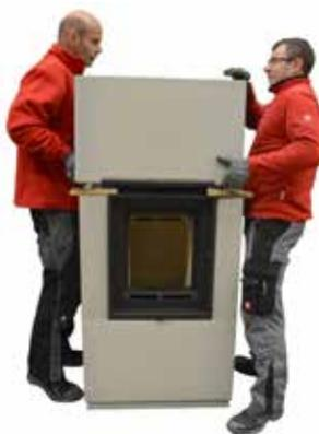
60. Oberbauteil **ohne zu verkleben** vorsichtig auf die Seitenteile setzen. Montageerleichterung entfernen und ausrichten.
