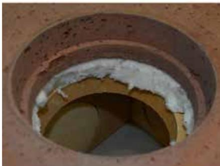
52. Spanngurt entfernen und am Anschluss oben mit einem Messer das Abdeckvlies ausschneiden.
