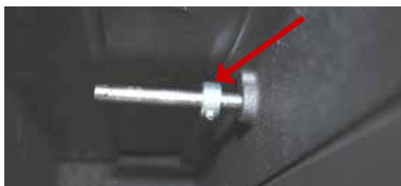
25. Bevor Sie die obere Umlenkswelle jetzt weiter bis durch die Öffnung in der vorgesetzten Zarge schieben, muss der Stelling auf die obere Umlenkswelle gesetzt werden!
