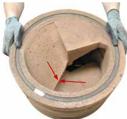
55. Vor der Drehzugmontage den Drehzug bereits auf der Palette durch Verdrehen einstellen (**nur bei Wandanschluss**). Die Kantenlinie der Übergänge muss übereinander liegen (siehe Pfeil).
