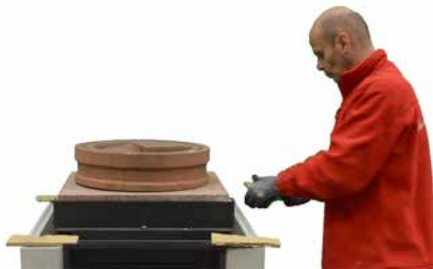
59. Zur Montageerleichterung bitte aus den Verpackungstreifen der Anlage, die Faserplatten auf allen vier Ecken doppelt auflegen.
