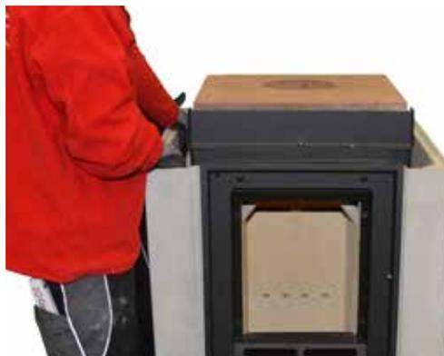
53. Seitenteile **ohne zu verkleben** rechts und links auf die Unterbauteile setzen und zur Türzarge ausrichten.
