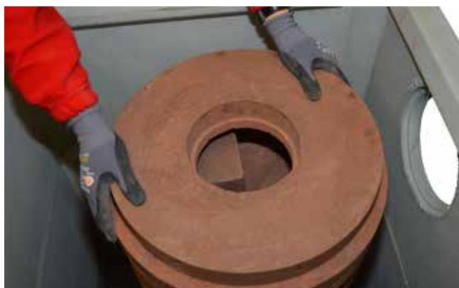
77. Abschluss-Schamottering mit Anschluss zur Decke auflegen.
