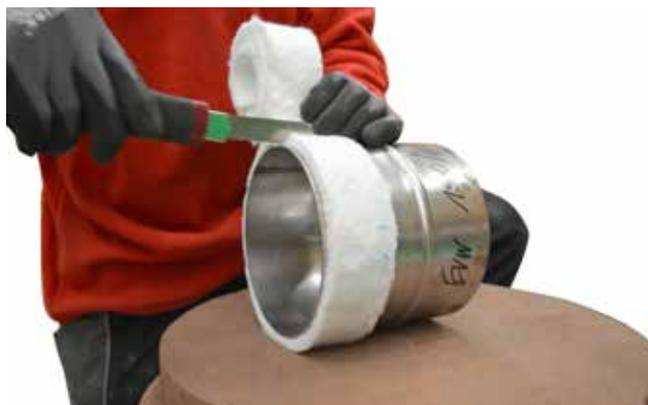
67. Rohrerweiterung vorbereiten. Bitte das Dichtungsvlies um den  $\varnothing 150$  mm wickeln und passend schneiden.
