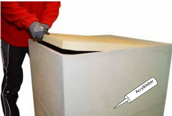
81. Alle Teile mit Acrykleber neu setzen und die Innen-Deckenplatten (5 cm Vermiculite) von oben in die Anlage einlegen.
