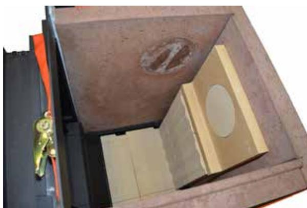
45. Rückwandstein oben mit Verschlussdeckel setzen.
