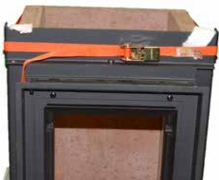
39. Außenschale zur weiteren Montage z.B. mit einem Spanngurt sichern.
