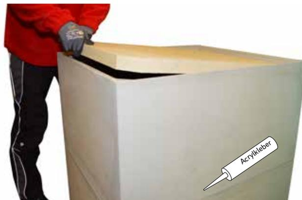
74. Alle Teile mit Acrylkleber neu setzen und die Innen-Deckenplatte (5 cm Vermiculite) von oben in das Haubenteil einlegen.
