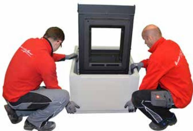
10. Vorderes Unterbauteil **ohne zu verkleben** auf die Bodenplatte setzen und ausrichten.
