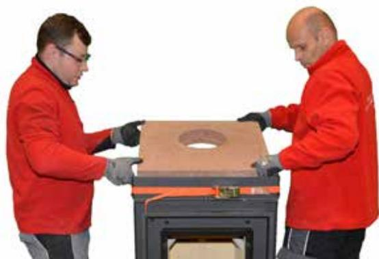
51. Abdeckplatte der Außenschale auflegen. Das Verkleben mit den Seitenteilen und der Rückwand erfolgt erst nach der Trockenmontage der Anlage.
