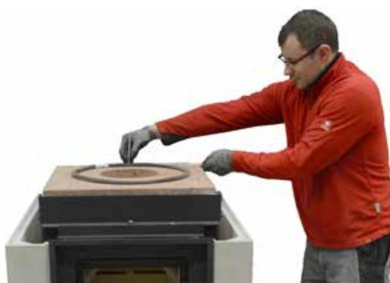
57. Anschließend eine Montagehilfslinie in der Mitte der Abdeckplatte zur Hinterkante zeichnen (**nur bei Wandanschluss**).
