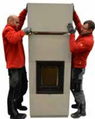
64. Zur Montageerleichterung bitte die Faserplatten erneut auf allen vier Ecken auflegen und das Haubenteil **ohne zu verkleben** setzen (dann die Faserplatten wieder entfernen).
