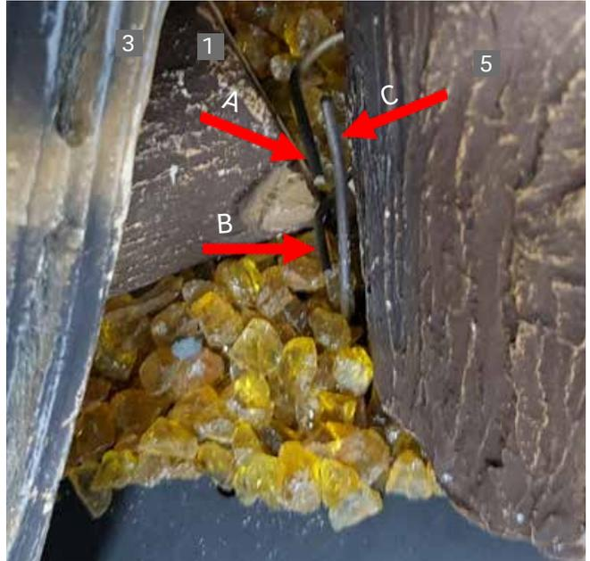
Abbildung 9: Position der Ionisation (A), Zündung (B) und Erdung (C). Der Abstand der Ionisation und der Zündung zur Erdung darf nur zwischen 3 mm bis 7 mm betragen. Achten Sie darauf, dass die Zünd- und Ionisationselektrode frei liegen und keinen Kontakt zueinander bzw. zu den Keramik Holzscheiten oder zum Dekorationsmaterial haben.
