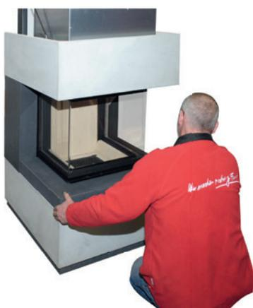
**15.** Verkleidungselement Nr. 8 oder Nr. 19 (Feuertisch oder Bankelement) **ohne zu Verkleben** auf das erste Verkleidungs-Element setzen und vorsichtig zur Wand schieben! Kamineinsatz evtl. nachjustieren.
