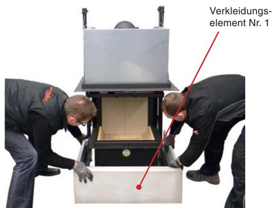
6. Tragrahmen aushängen (**nur bei S14 und S15**) und Verkleidungselement Nr. 1 **ohne zu Verkleben** von oben gegen die Wand setzen.
