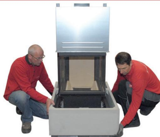
12. Tragrahmen aushängen (nur bei S14 und S15) und Verkleidungselement Nr. 16 **ohne zu Verkleben** von oben gegen die Wand setzen.
