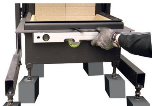
3. ...und mit Wasserwaage ausrichten.
