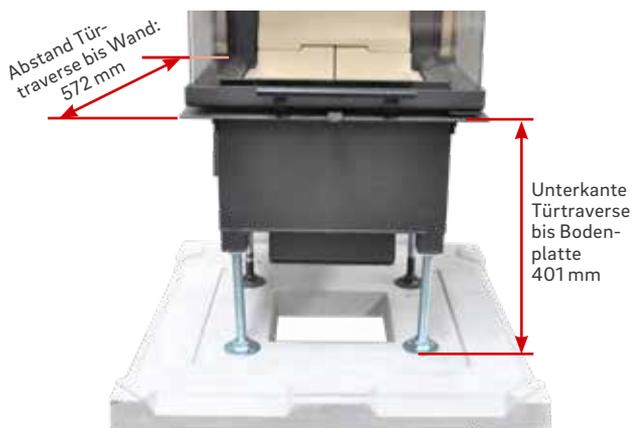
9. Kamineinsatz mit den vorderen Stellfüßen mittig auf der Kreuzmarkierung der Bodenplatte positionieren und mit Hilfe der Verstellschrauben (SW 24) von Oberkante Bodenplatte aus, auf eine Höhe von 401 mm einstellen.
