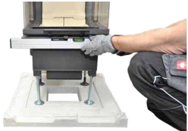
10. Kamineinsatz mit Wasserwaage ausrichten.
