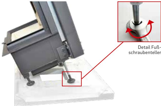
7. Kamineinsatz auf die Bodenplatte stellen, etwas nach vorne kippen und hintere Stellfüße auf 401 mm herausdrehen. Obere Sicherungsschraube mit einem Schraubenschlüssel (SW 24) wieder festziehen.
