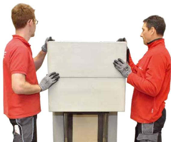
10. Zweites Oberbauteil oder drittes Oberbauteil (für Version S12 Kurz) **ohne zu verkleben** von oben auf das erste Oberbauteil setzen und ausrichten.
