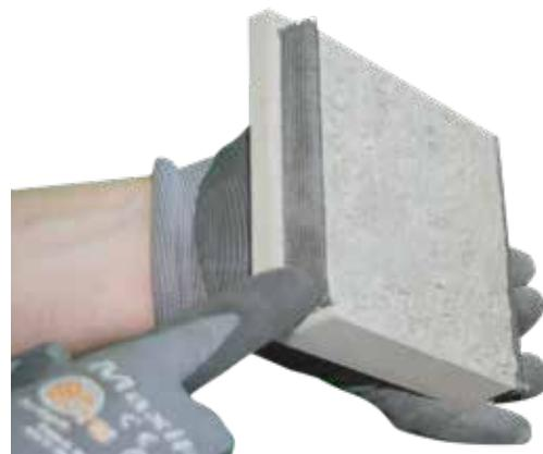
15. Seitliche Dichtbänder (120 mm) rechts und links am Revisionsdeckel aufkleben.
