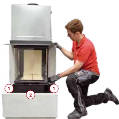
6. Zweites Seitenteil **ohne zu verkleben** auf das Unterbauteil setzen und ausrichten (Kamineinsatz evtl. nachjustieren).
