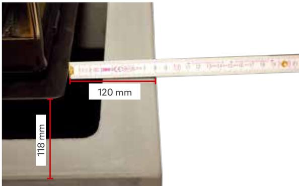
3. Kamineinsatz in der Anlage ausrichten. Abstand von der Vorderkante der Anlage bis zur Zarge = 118 mm, seitlich 120 mm.
