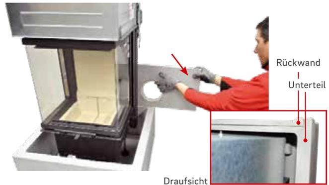
4. Rückwandmodul Höhe 309 mm mit Hinterlüftung und seitlichen Lufteinlässen nach unten **ohne zu verkleben** auf die Bodenplatte bzw. auf das zweite Unterbauteil setzen. Hinterlüftung zur Wandseite!
