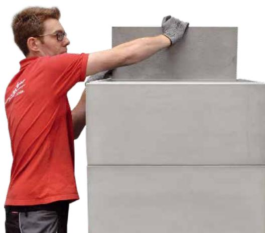
11. **Nur bei S 12 Hoch:** Obere Rückwand auf die mittlere Rückwand setzen.
