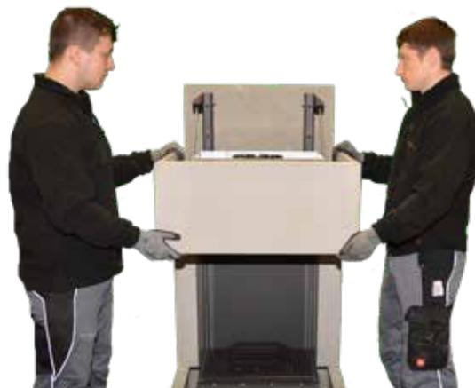
19. Erstes Oberbauteil **ohne zu Verkleben** mit der Falzseite von oben auf den Tragrahmen setzen und ausrichten. Tragrahmen ggf. nachstellen.
