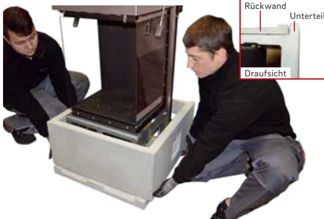
13. ..und Unterbauteil **ohne zu verkleben** von oben auf die Bodenplatte setzen.
