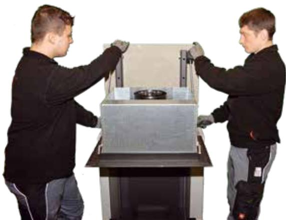
18. Mittlere Rückwand (Hinterlüftung zur Wand ausrichten) auf das Seitenteil (mit integrierter Hinterlüftung) setzen.
