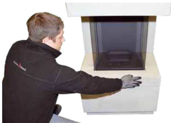
20. Bank **ohne zu verkleben** auf das Unterbauteil setzen und vorsichtig zur Wand schieben! Kamineinsatz evtl. nachjustieren.
