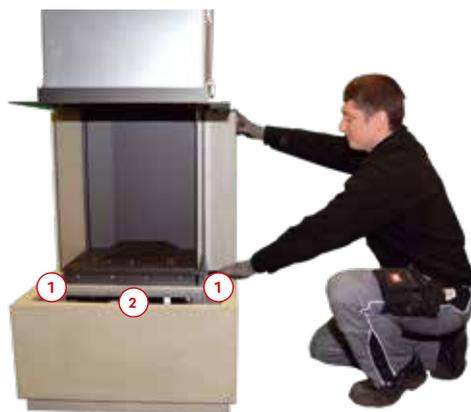
17. Zweites Seitenteil **ohne zu verkleben** auf das Unterbauteil setzen und ausrichten (Kamineinsatz evtl. nachjustieren).
