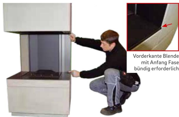
33. Stahl Seitenblenden 6 mm punktuell mit Acrylkleber vor die Seitenteile kleben.
