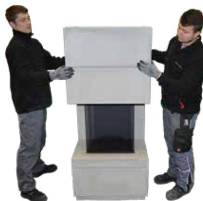
21. Zweites Oberbauteil oder drittes Oberbauteil (für Version S12G Kurz) ohne zu verkleben von oben auf das erste Oberbauteil setzen und ausrichten.
