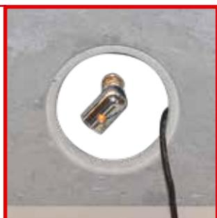
**⚠ HINWEIS:** Ausrichtung der Gassteckdose schräg nach unten!
